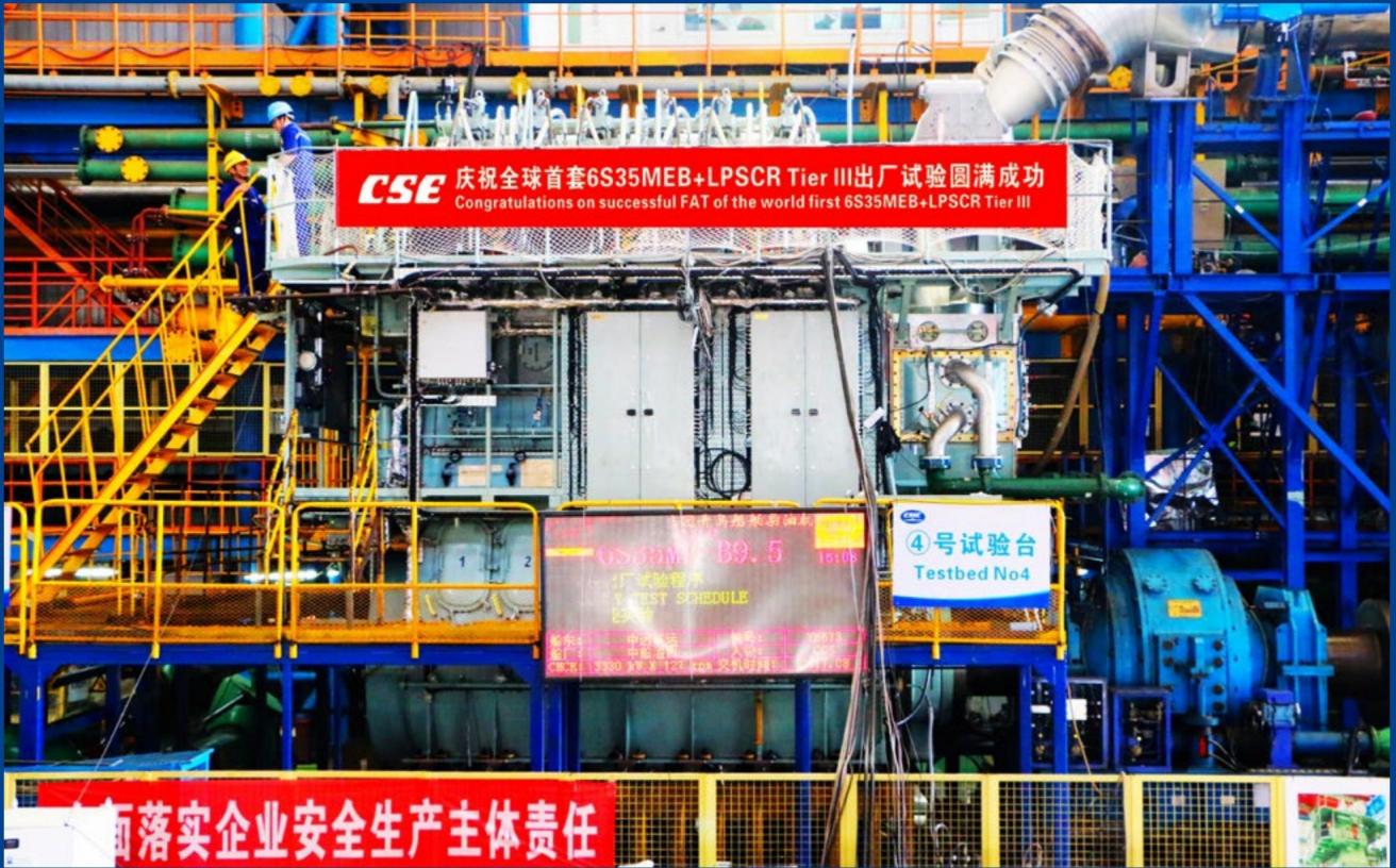
| 柴油机动力：中国船柴国内首套满足Tier III排放主机6S35MEB+LPSCR |
